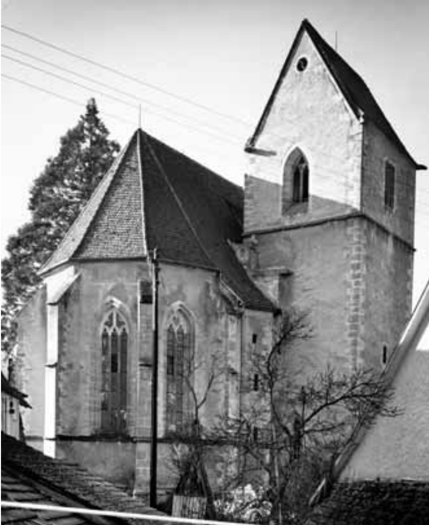
Abb. 16: Marienkirche Bronnweiler, Chor, Gesamtansicht des Außenbaus von Nordosten (Aufnahme 1966).
