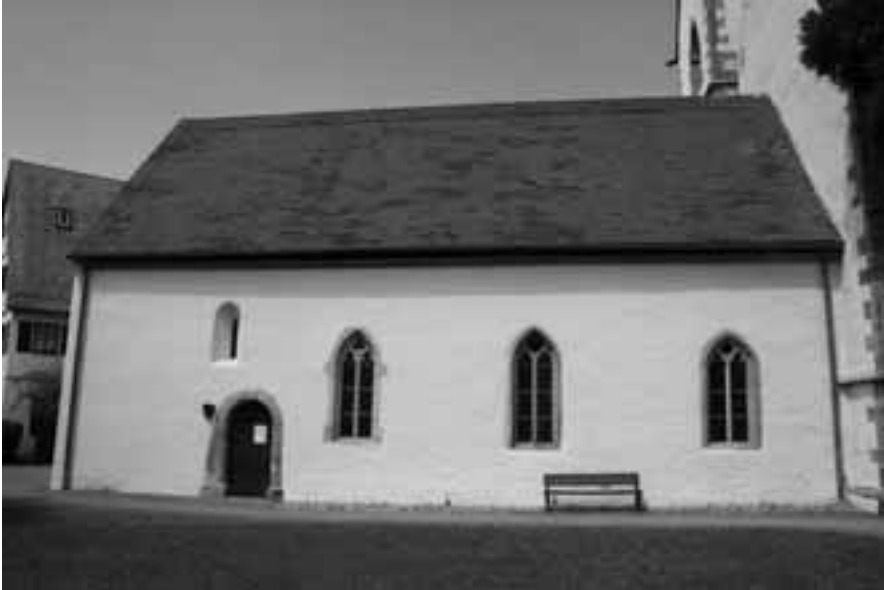
Abb. 4: Marienkirche Bronnweiler, Südfassade des Schiffes (Aufnahme 2010). Ansicht der bis 1415 am Ort bestehenden romanischen Kirche mit erhaltenem kleinen romanischen Fenster im Westen und zwei vollgotischen Fenstern (14. Jahrhundert) im Osten der Wandfläche. Das dritte spitzbogige Fenster in der Mitte stellt eine Neuerung aus dem 19. Jahrhundert dar.
