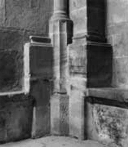
Abb. 10: Marienkirche Bronnweiler, Sakristei, Säulenbasis mit unterschrittenem Übergang zur Kehlung.
