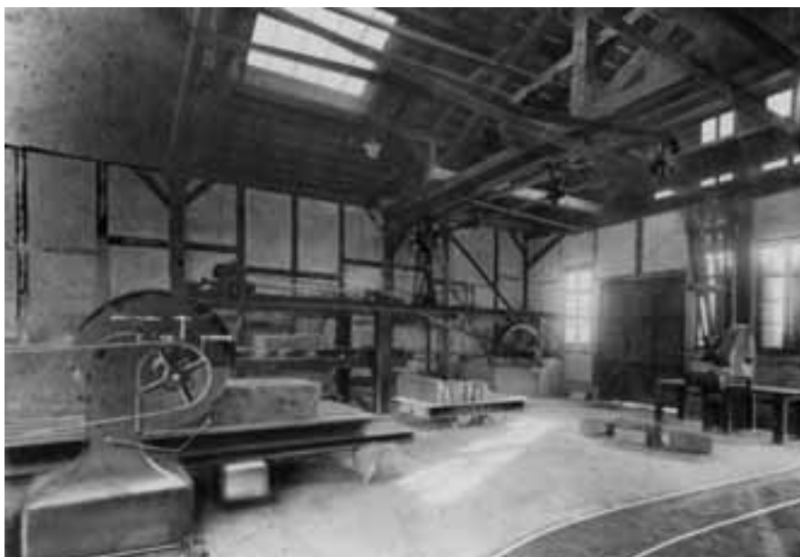
Abb. 13: Die Werkshalle mit der Kreissäge.
