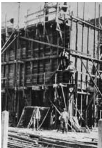
Abb. 7: Wiederaufbau des Werkes, vermutlich 1919.
