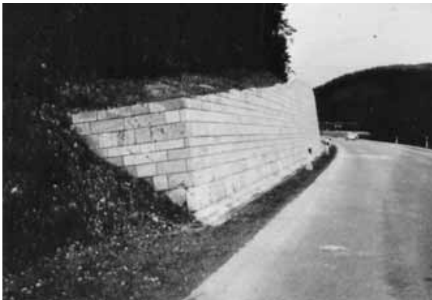
Abb. 17: Stützmauer am Albaufstieg der Autobahn, um 1937.
