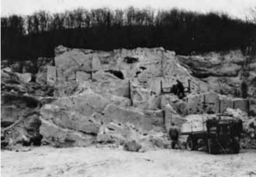
Abb. 10: Abbau mit Hilfe der Korffmannschen Schrammsäge.
